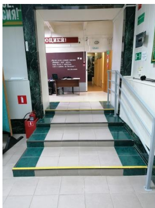
Фото № 44 (Пути эвакуации (в т.ч. зоны безопасности) внутрь двора
