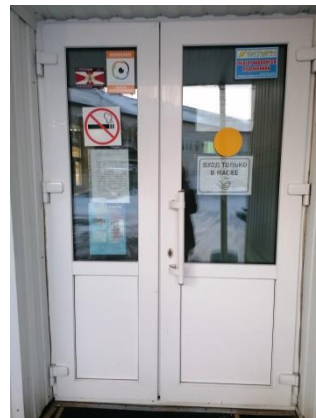
Фото № 30 Дверь (входная)
