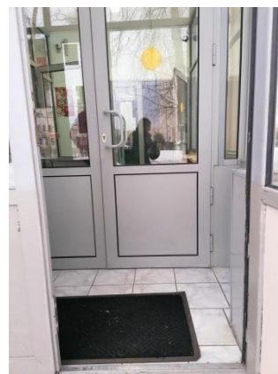
Фото № 37 Тамбур (дверь входная) в «Военно-исторический музей»
