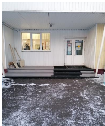
Фото № 28 Главный вход МБУ ДОЦ «Витязь» (Лестница наружная)
