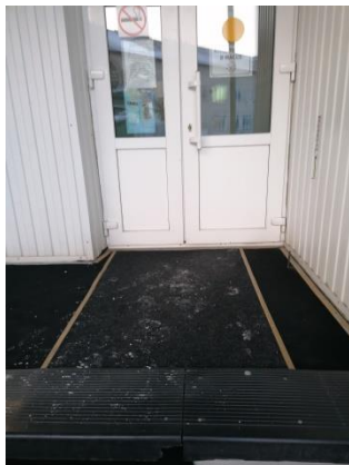
Фото № 29 Входная площадка перед дверью
