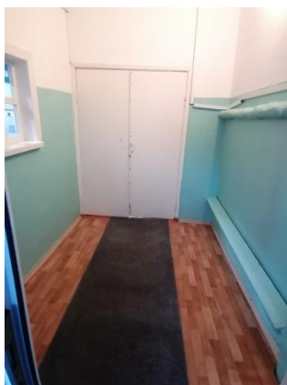
Фото № 35 Тамбур (дверь входная)
