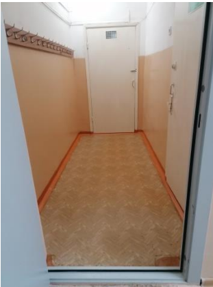
Фото № 42 (Пути эвакуации (в т.ч. зоны безопасности) внутрь двора)
