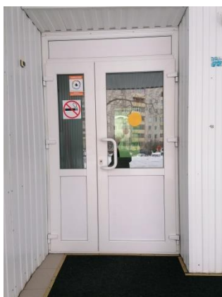
Фото № 31 Дверь (входная) в «Зеленогорский кадетский корпус»
