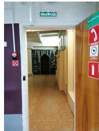
Фото № 43 (Пути эвакуации (в т.ч. зоны безопасности) на ул. Строителей в ВИМ)
