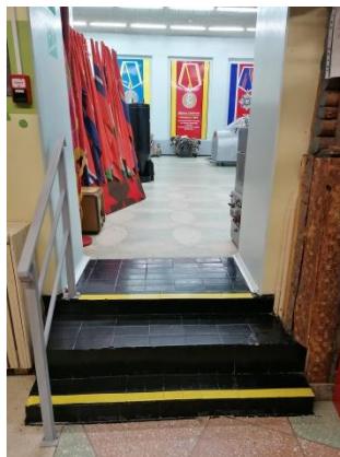
Фото № 43.2 Пути эвакуации на ул. Строителей в ВИМ
