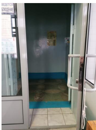
Фото № 37.1 Тамбур (дверь входная) в «Военно-исторический музей»
