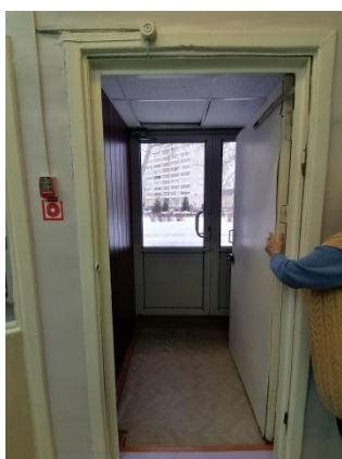
Фото № 39 Тамбур (дверь эвакуационная) из «Зеленогорский кадетский корпус»
