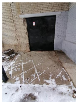
Фото № 36 Дверь (эвакуационная) из «Военно- исторического музея» на ул. Молодёжная
