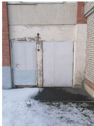
Фото № 31 Дверь (эвакуационная на ул. Песчаная)
