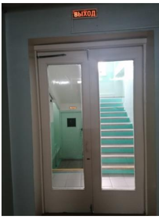
Фото № 41 Путь эвакуации на ул. Строителей
