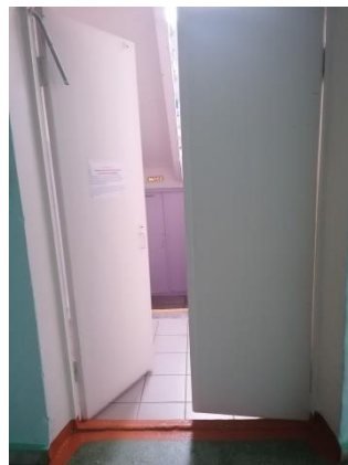
Фото № 39 Дверь на 1 этаже, ведущая на лестницу (внутри здания)
