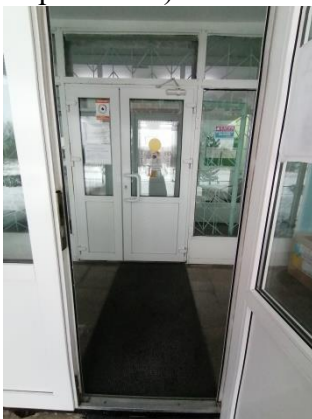
Фото № 33 Тамбур (дверь входная)
