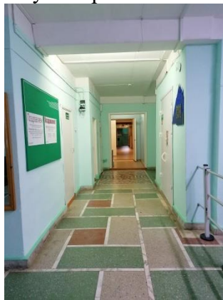
Фото № 42.2 Путь эвакуации на ул. Песчаная
