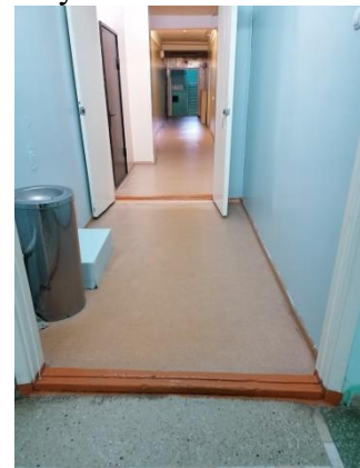
Фото № 42.3 Путь эвакуации на ул. Песчаная
