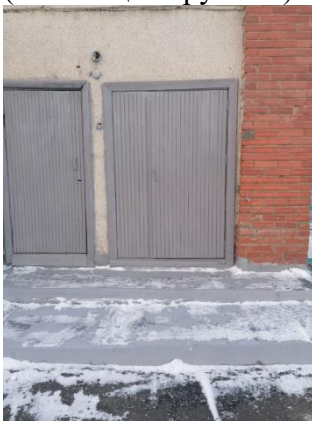
Фото № 30 Дверь (эвакуационная на ул. Строителей)
