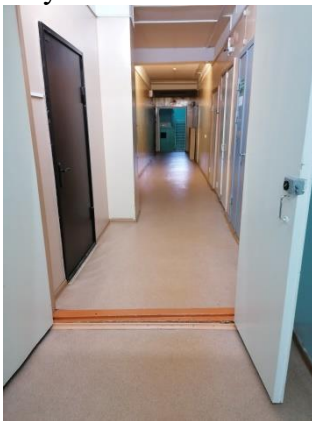
Фото № 42.4 Путь эвакуации на ул. Песчаная
