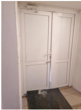
Фото № 36 Тамбур (эвакуационный выход во двор)
