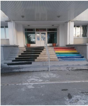
Фото № 27 Главный вход МБУ ДОЦ «Витязь» (Лестница наружная)
