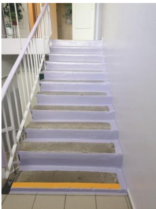
Фото № 38.2(Лестница внутри здания)
