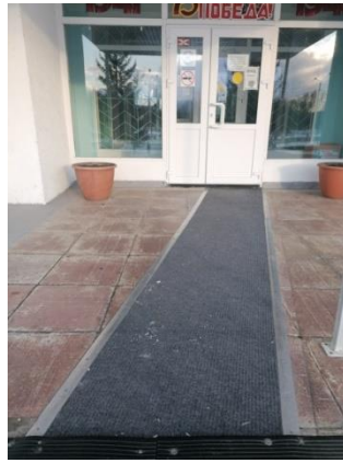
Фото № 28 Входная площадка перед дверью
