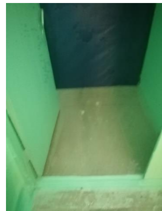
Фото № 34 Тамбур (эвакуационный выход на ул. Строителей)
