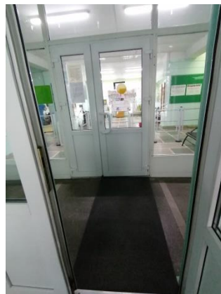
Фото № 33.1 Тамбур (дверь входная)
