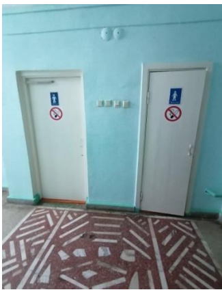
Фото № 49 Туалетная комната
