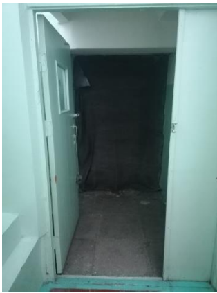
Фото № 35 Тамбур (эвакуационный выход на ул. Песчаная)
