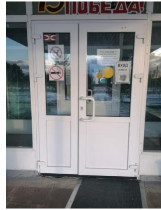
Фото № 29 Дверь (входная)
